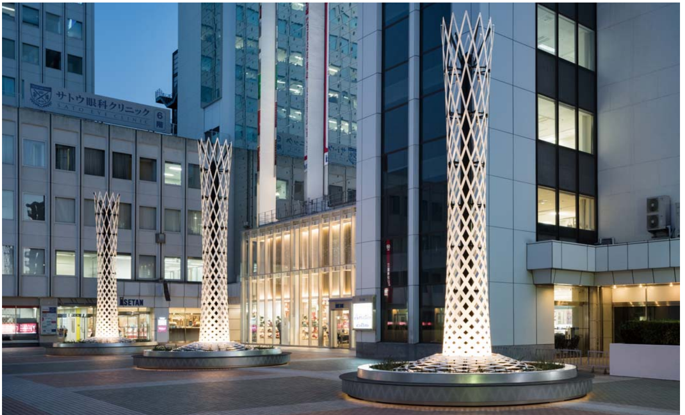
SPIRAL TREE -M PLAZA RENOVATION- スパイラルツリー ～M 広場リノベーション～ 2015
